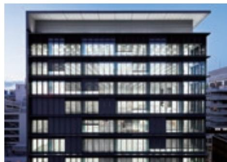
エコシェイドは窓の外で日射熱を防ぎ空調負荷を減らしオフィス環境の快適化・ビルの省エネを実現します。スラット角度調整でやわらかな光を反射させ、快適な空間を演出します。
