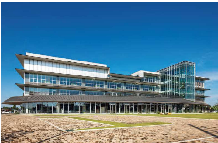
下野市役所 栃木県下野市
